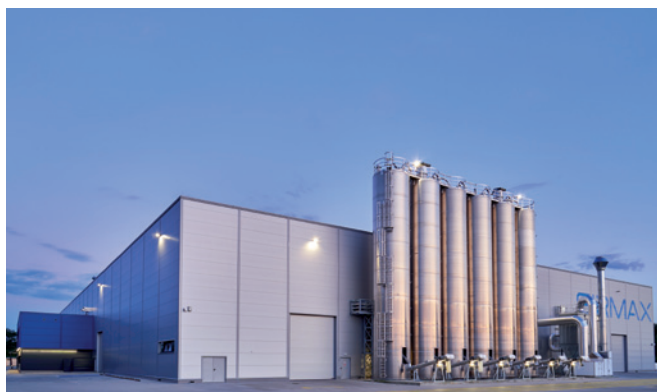
Zakład Kutno 2 to nowa inwestycja Sirmax w Polsce. Zakład pracuje od początku 2020 r. i produkuje elastomery termoplastyczne, wybrane tworzywa konstrukcyjne oraz tworzywa niepalnione
